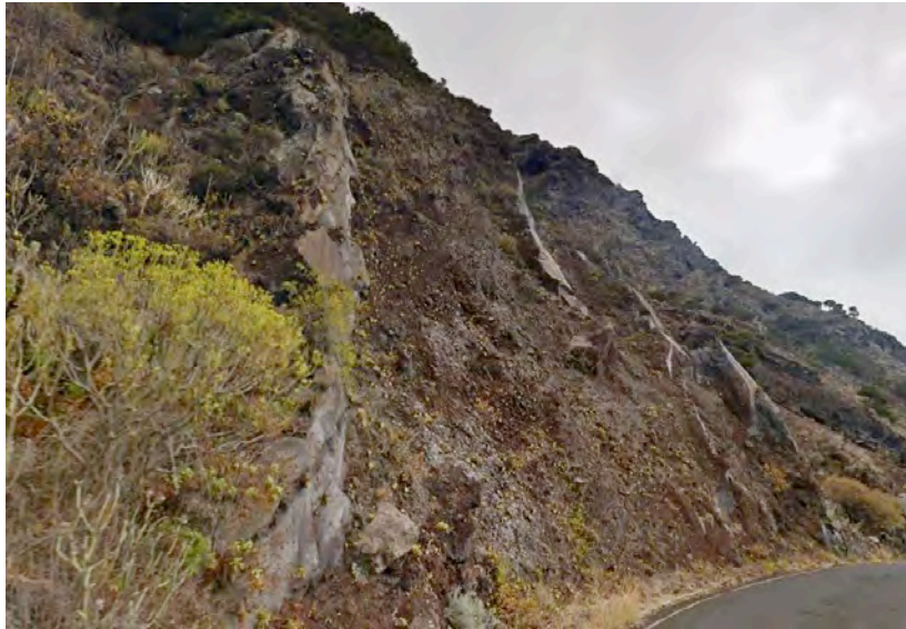
Figura 12. Diques en la pared.
