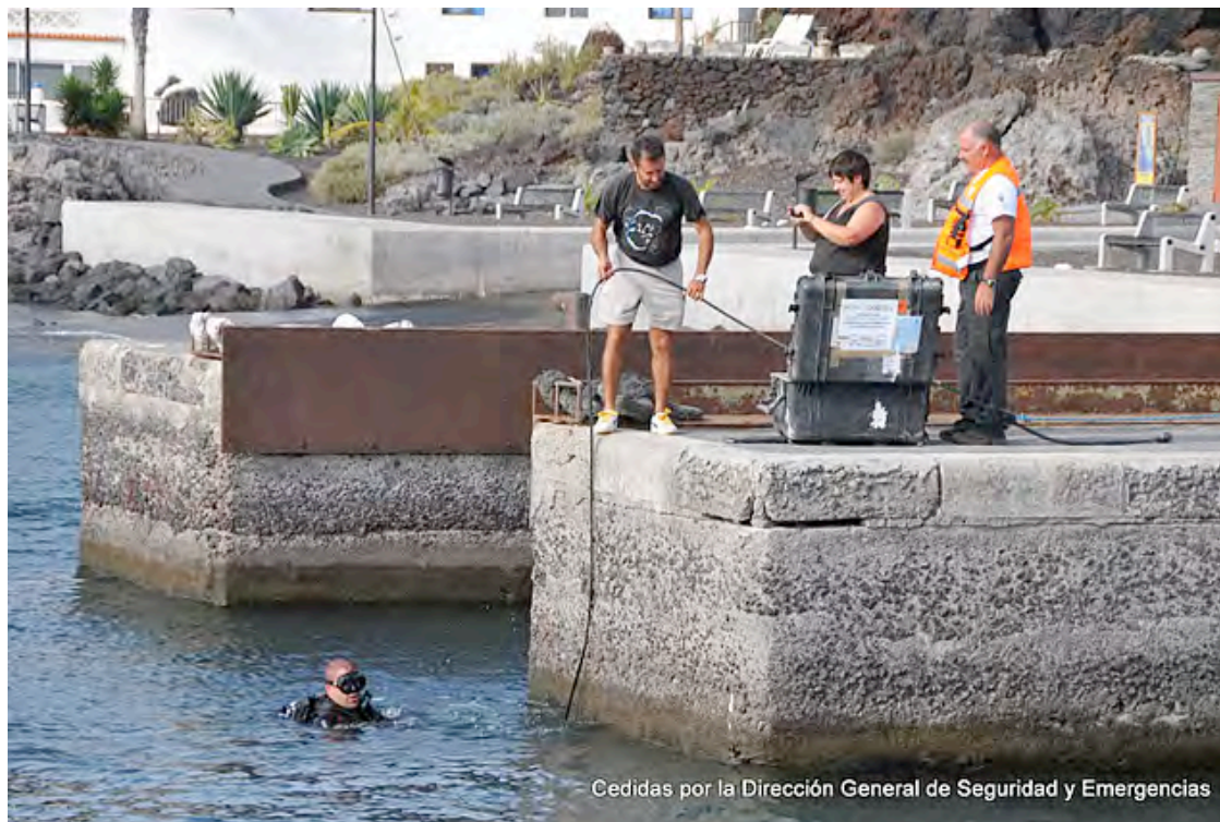
Figura 18. Instalación de geófonos en el muelle de La Restinga
