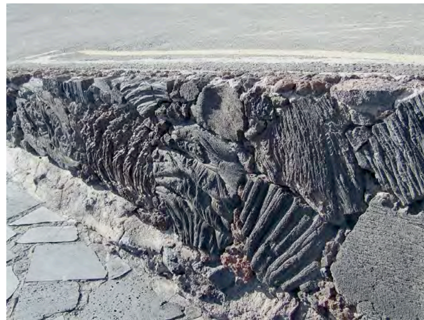
Figura 42. Uso de lavas para la construcción de muros con evidente deterioro de las formaciones originales
