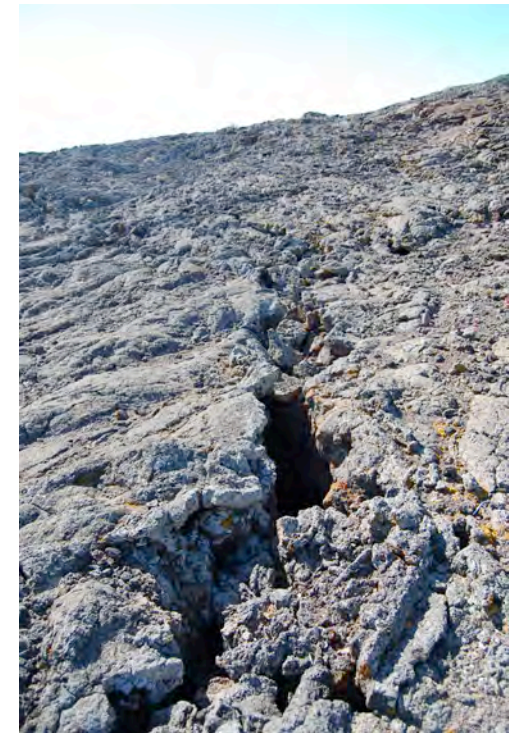
Figura 22. Hundimiento en techo de túnel
